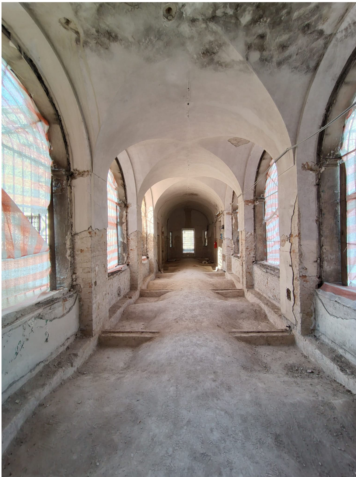
Il corridoio centrale: estradosso delle volte ripulite con frenelli e catene in vista
