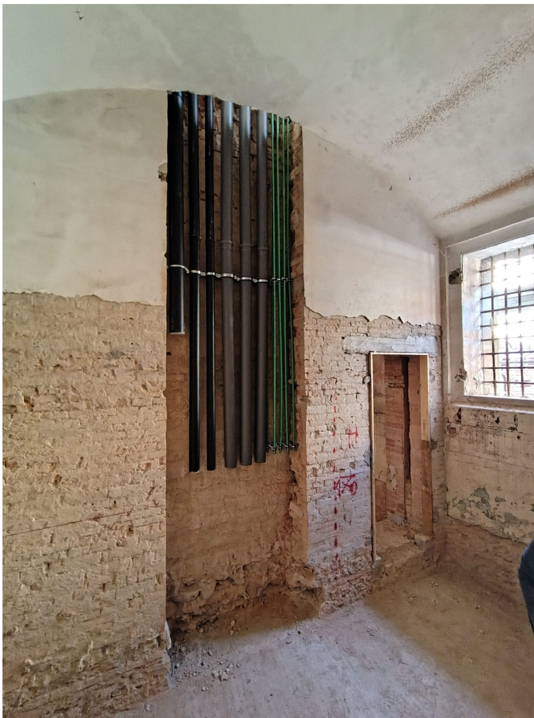
Perizia Suppletiva e di Variante 02: prototipo per l'alloggiamento degli attraversamenti impiantistici nell'intercapedine della muratura di separazione tra le future stanze attrezzate.
