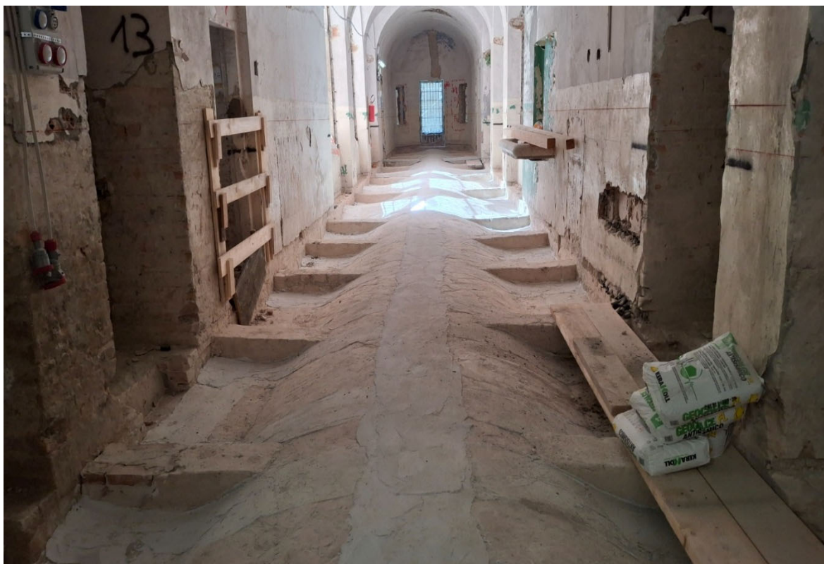
Intervento di rinforzo delle volte con posa di fibra di acciaio
