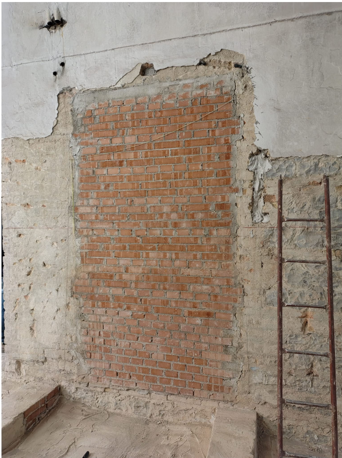
Chiusura delle nicchie e delle brecce murarie lungo i corridoi principali
