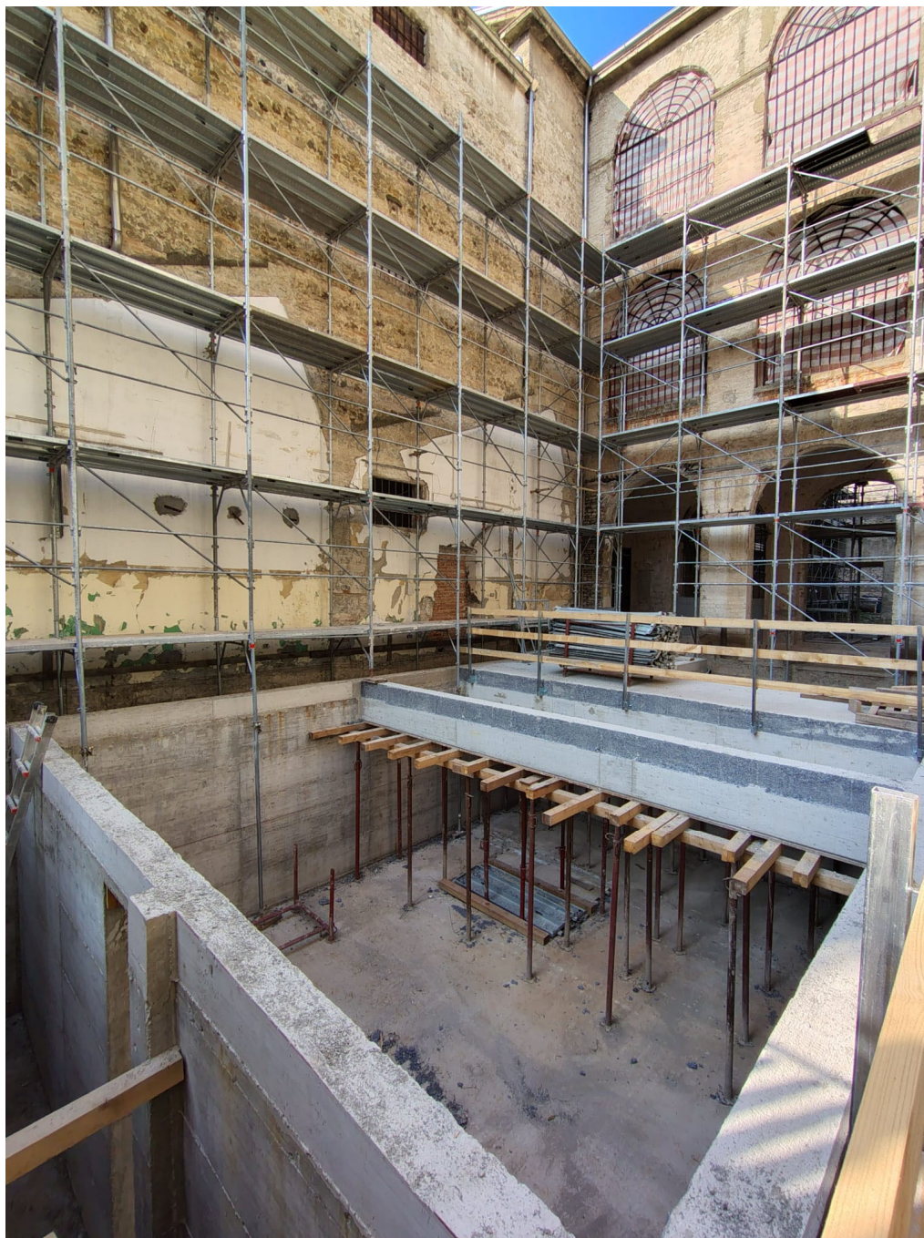
Formazione dei nuovi vani tecnici interrati
