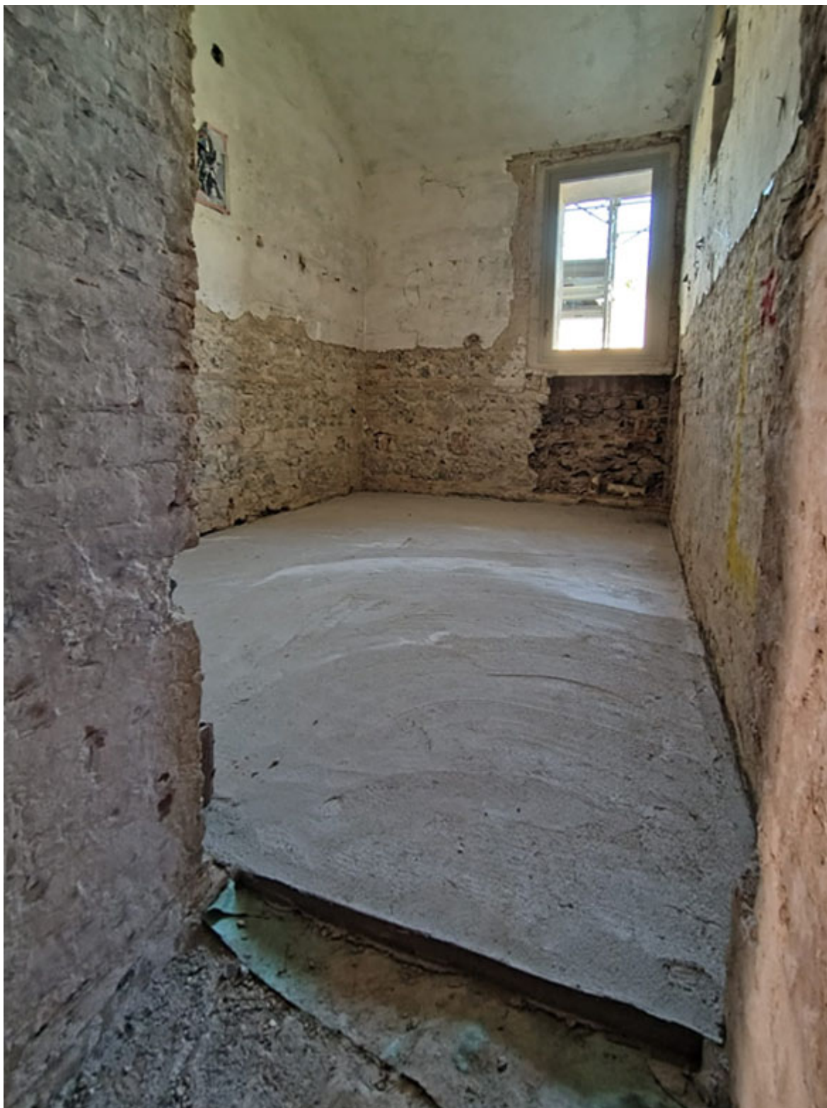
Prova per l'esecuzione dei nuovi massetti all'interno delle future stanze attrezzate e posa di serramento campione sulla parete perimetrale esterna
