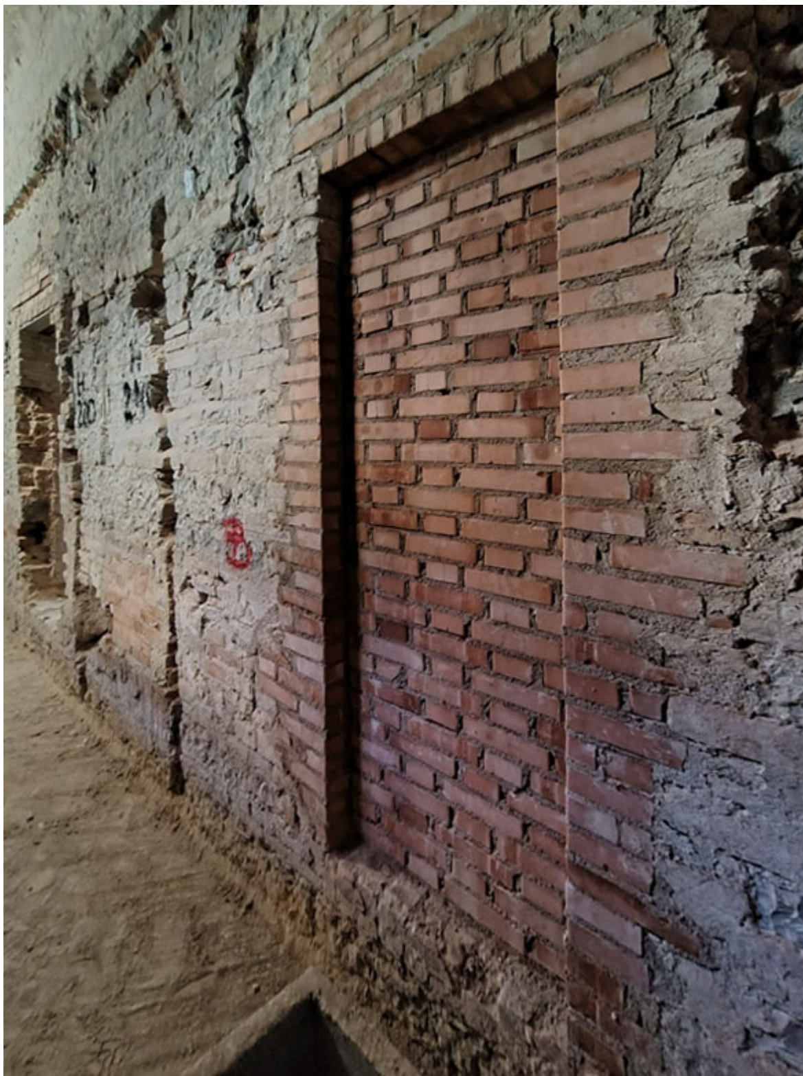
Chiusura delle aperture non necessarie lungo i corridoi laterali con mantenimento della sagoma di riferimento delle vecchie aperture
