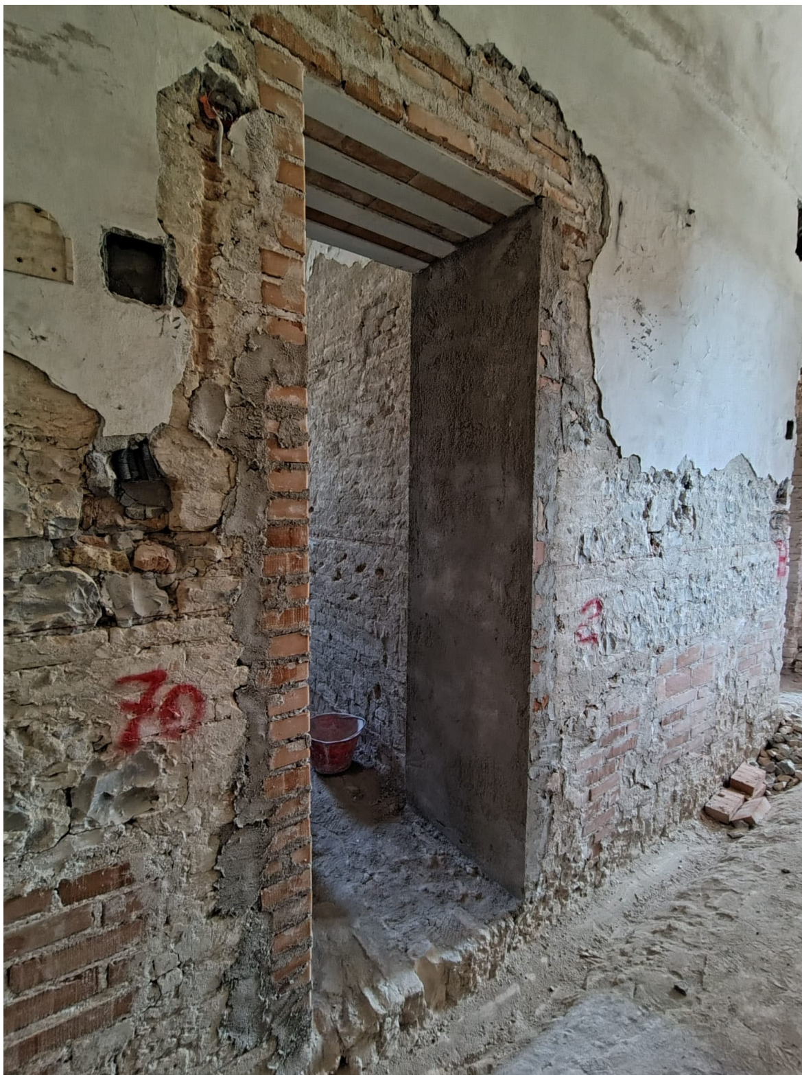
Fornazione di nuovi architravi e riquadratura delle porte di accesso alle future stanze attrezzate
