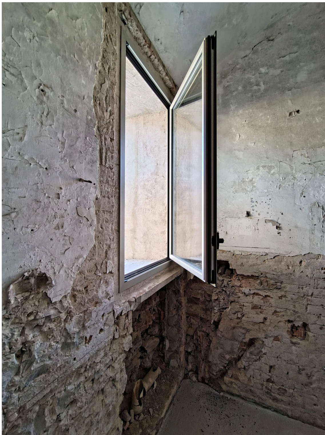
Posa di serramento campione (opzione B) per valutazione estetico-funzionale con la competente Soprintendenza
