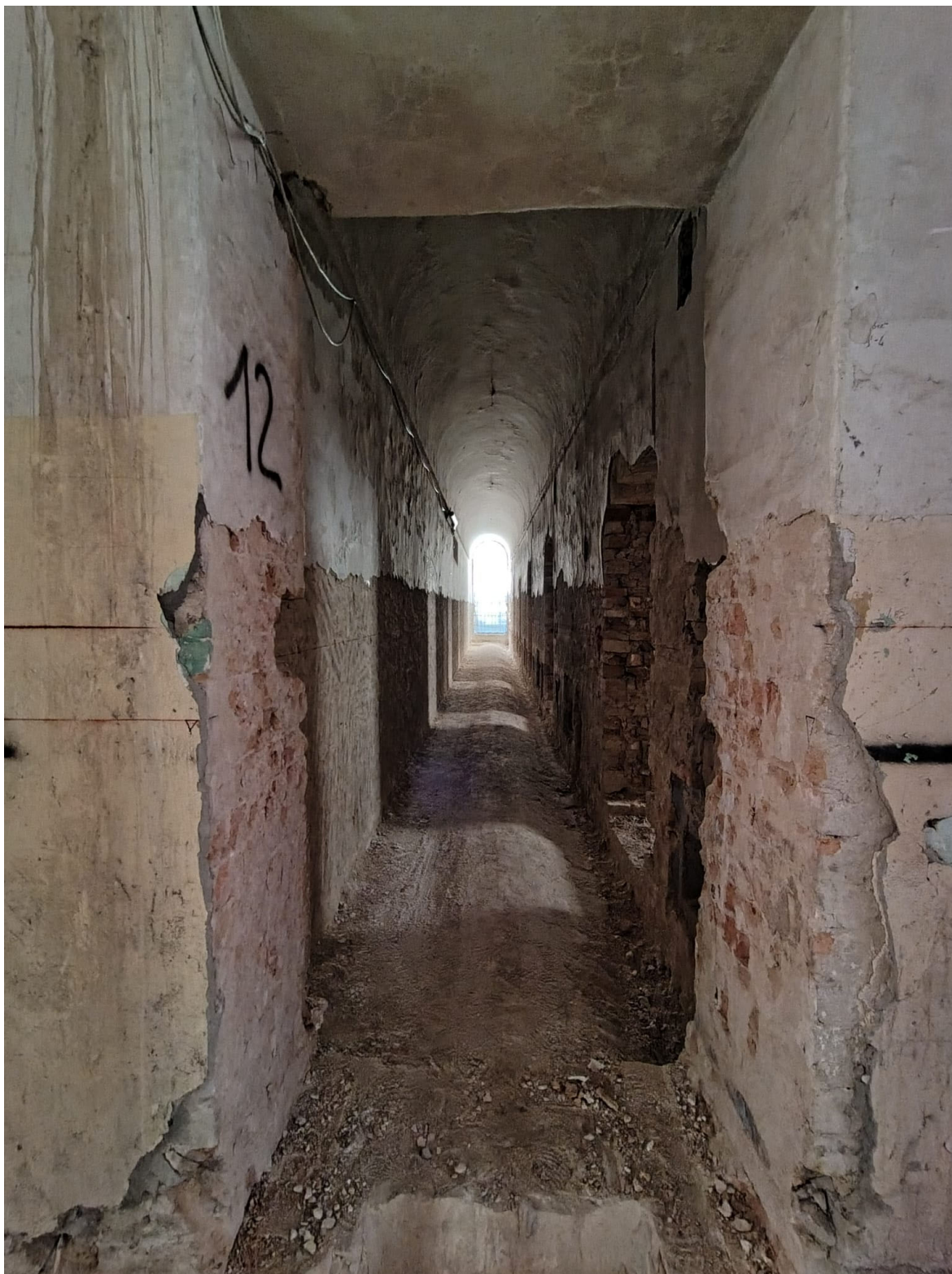
Demolizione di intonaci ammalorati e delle pavimentazioni lungo i corridoi laterali
