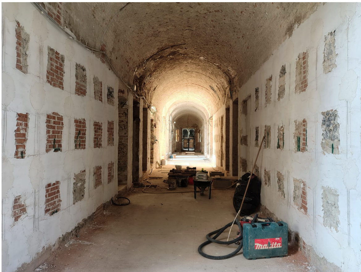
Intervento di rinforzo delle murature interne con posa di fibra di acciaio lungo i corridoi principali
