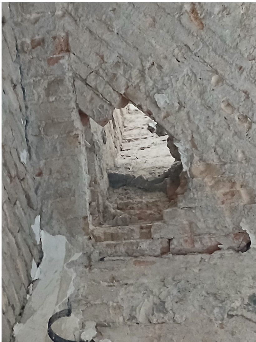
Perizia Suppletiva e di Variante 02: esempio di foro di attraversamento del solaio da richiudere per il consolidamento delle volte con evidenza della tessitura in mattoni da ripristinare.
