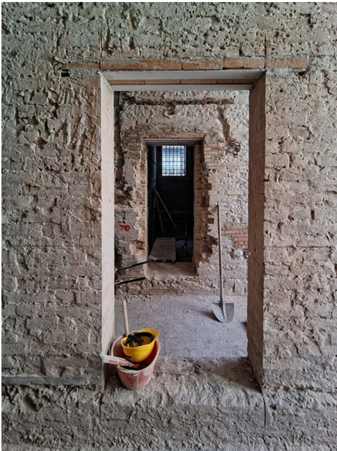
Formazione di nuovi architravi e riquadratura delle porte di accesso alle future stanze attrezzate
