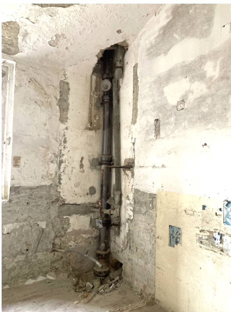
Stato di fatto: vista di una colonna di scarico angolare esistente e del relativo foro di attraversamento della volta e della pavimentazione.
