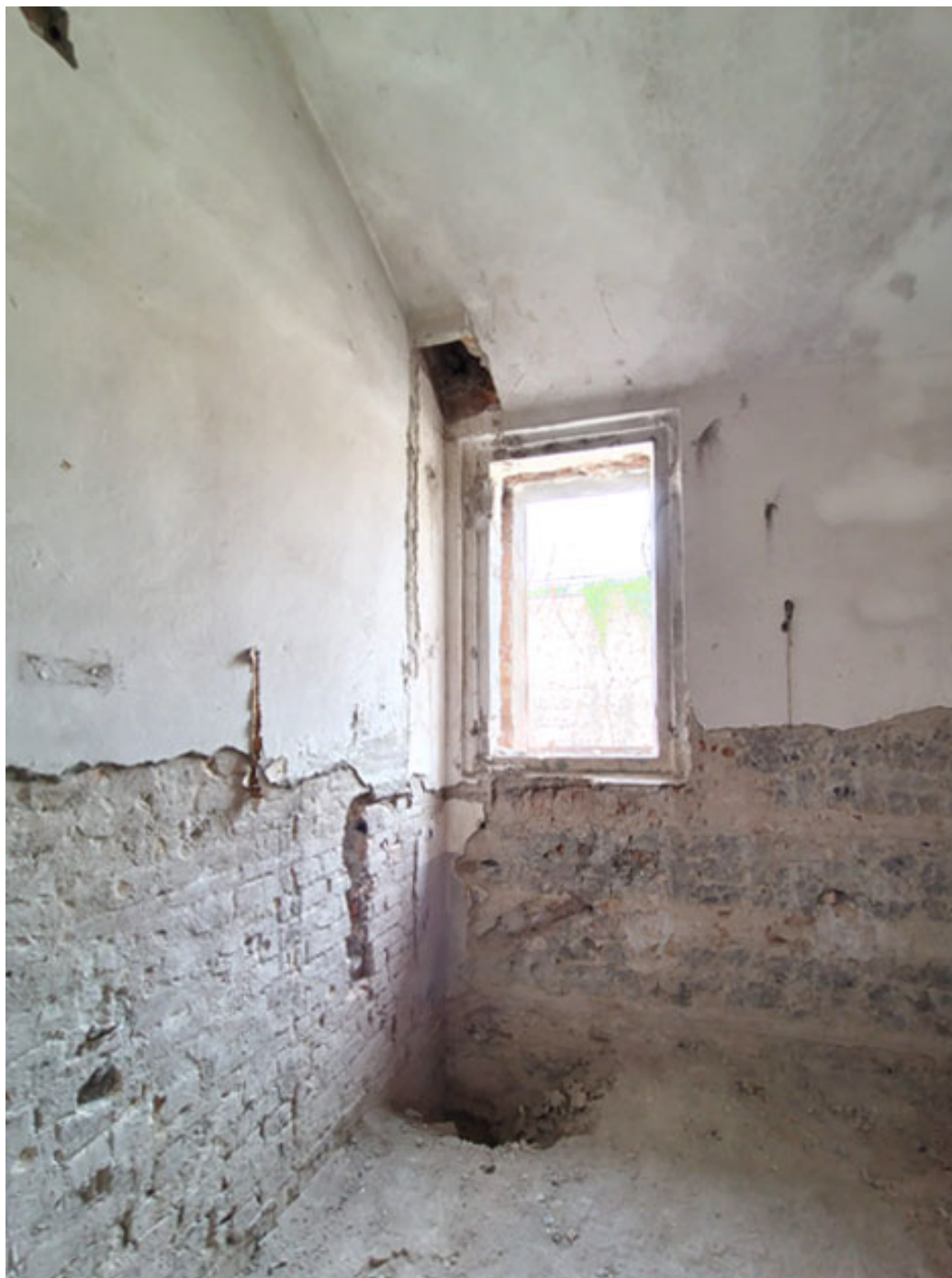
Perizia Suppletiva e di Variante 02: esempio di foro di attraversamento del solaio, da richiudere per il consolidamento delle volte e potenzialmente interferente con la finestra esistente
