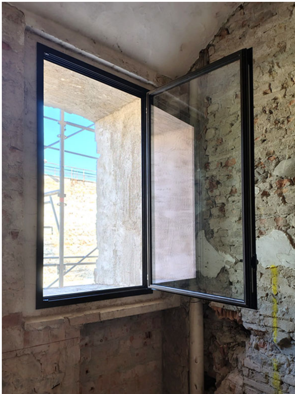
Posa di serramento campione (opzione A) per valutazione estetico-funzionale con la competente Soprintendenza
